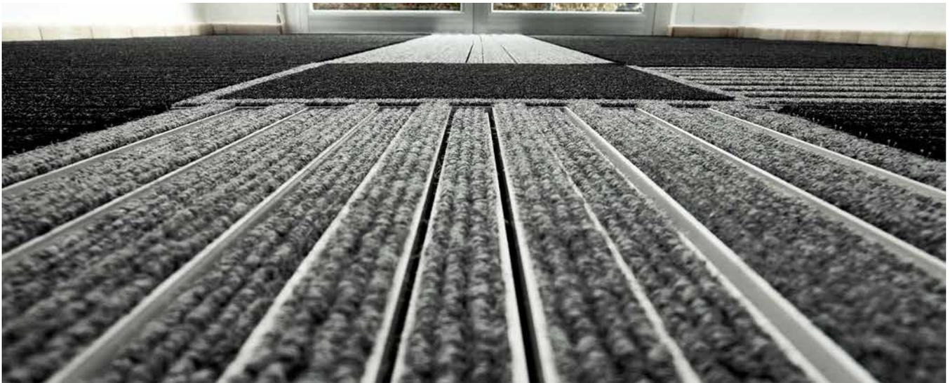
Längs zur Gehrichtung verlaufende Aluminiumprofile mit leicht unterschiedlichen Höhen sind sowohl mit der Fußsohle als auch mit dem Blindenstock fühlbar.
