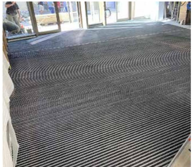
Typ C mit Rechteckrohrprofilen
